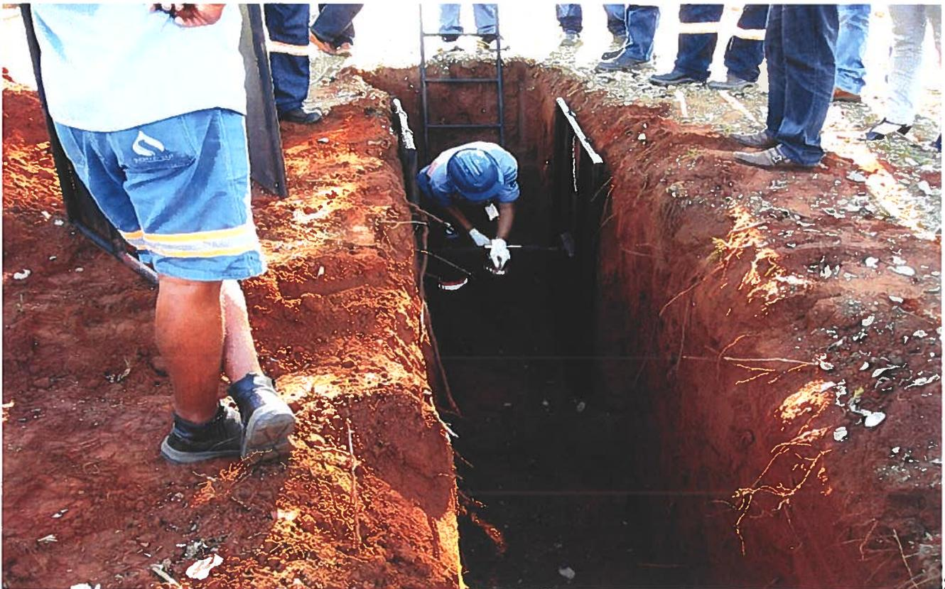
Deverão também ser respeitando os espaçamentos entre as placas, que deverá ser de um metro em solo firme e seco ou uma ao lado da outra sem espaçamento em solo arenoso ou úmido como nas imagens a seguir:
